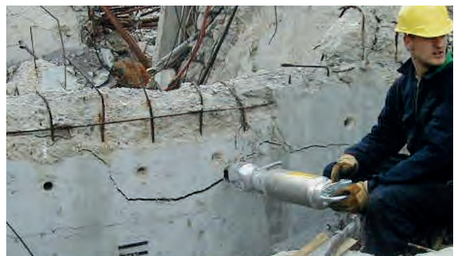
Spalten durch Pressen – Keilprinzip
